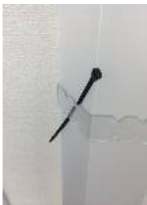
①チューブとリングの間に、固定紐を通す
